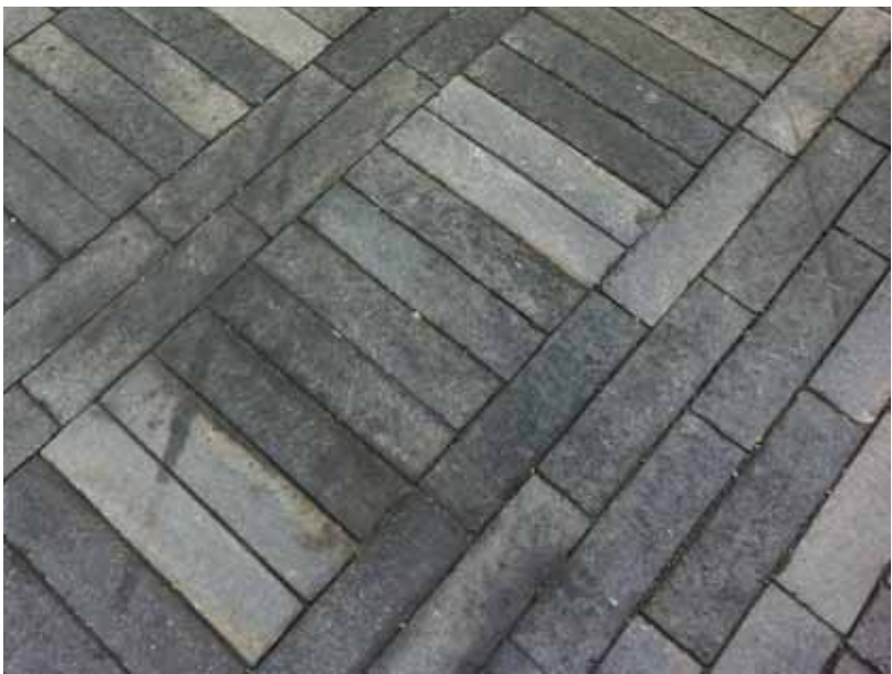
Teglklinkerne har et aflangt format, der giver mulighed for forskellige belægningsmønstre.
