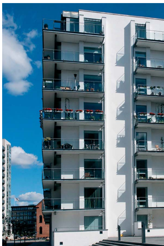
Reference på facade materiale Filtset lyst murværk Bryggens Have, København Kim Utzon Arkitekter
