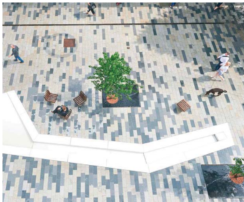
Eksempel på belægning med betonfliser i forskellige nuancer
