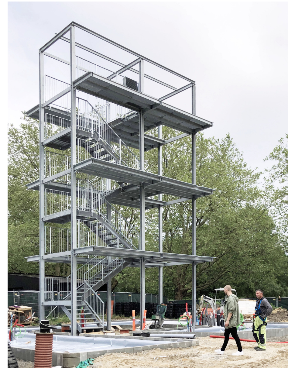
Foto af trappe ved Venligbolig Plus - Frederiksberg - udført af DS stål
