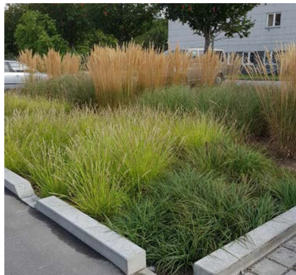
Regnbet i Irmabyen. Regnvand fra vejen ledes ned i regnvandsbedet.
