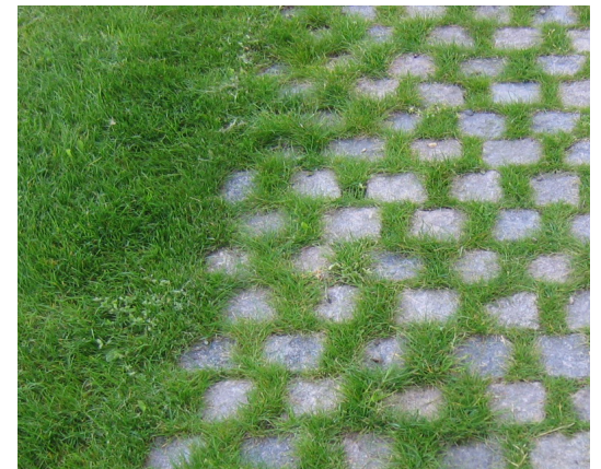
OVERGANG FRA GRÆS TIL CHAUSSESTEN
