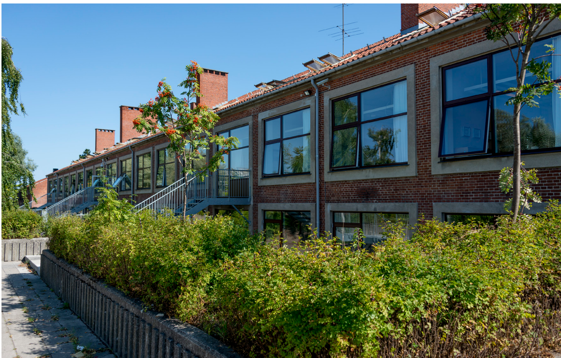
På Islev Skole er der blandt andet foretaget isolering af loftet i festsalen, hulmursisolering og vinduesudskiftninger.
