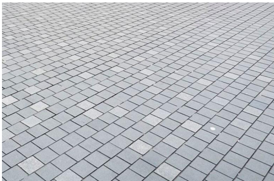
Der lægges savskårne og jetbrændte chaussésten i de primære gangarealer og omkring opholdspladser, bænke og indgangssituationer.
