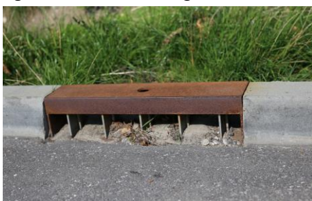
Figur 9 Eksempel på rist i kantsten
