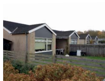
Gule rækkehuse m. vinkeludbygning og beskyttede terrasser.
