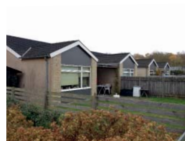
Gule rækkehuse m. vinkeludbygning og beskyttede terrasser.
