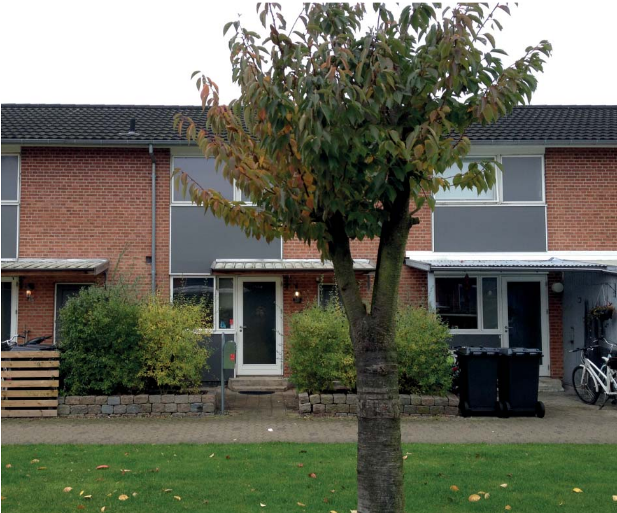
Eksisterende indgangspartier mod øst, set fra det grønne friareal mellem de røde rækkehuse. Interne gangstier mellem forhaver og fællesarealer.
