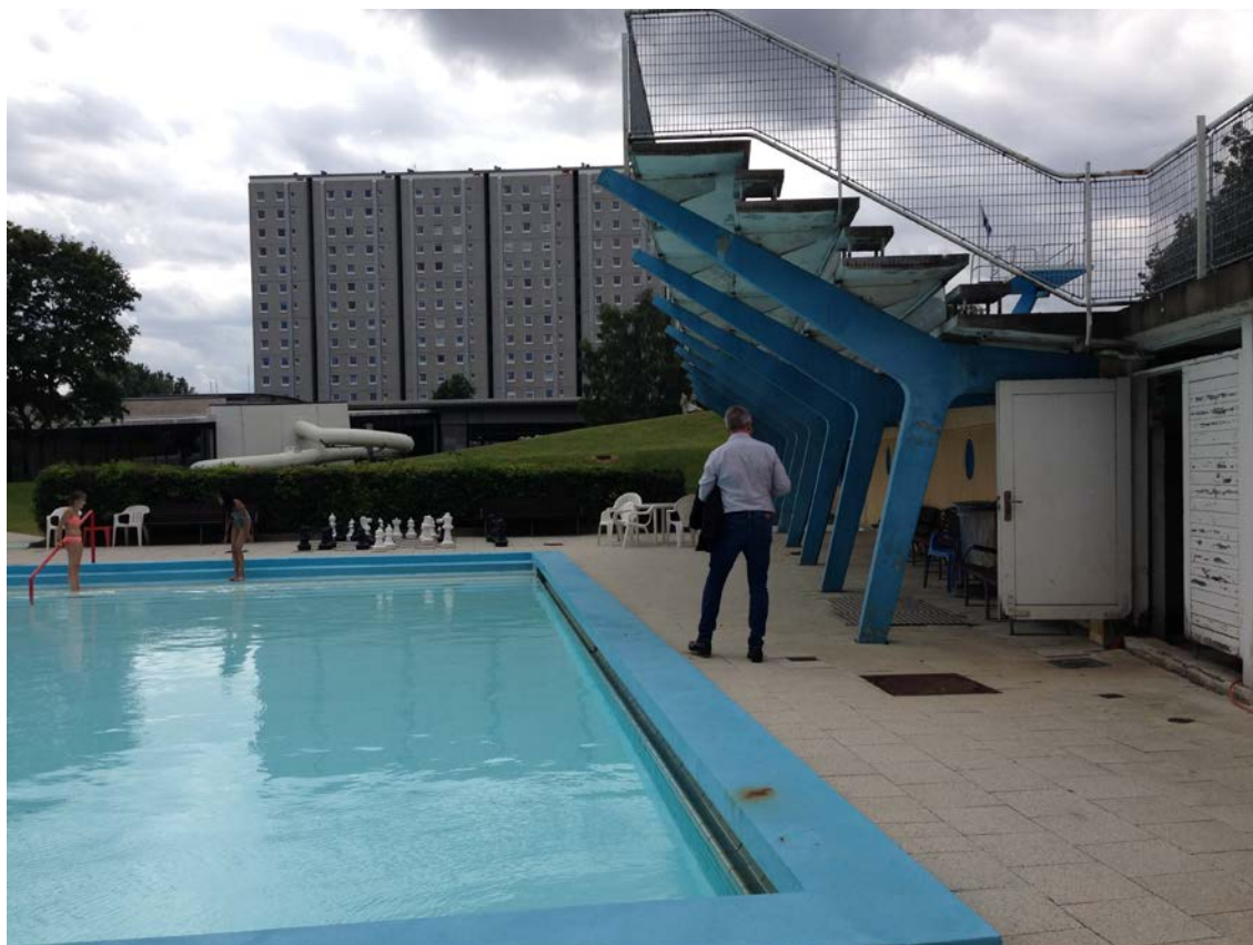
Eksisterende toiletter som ombygges – til højre i billedet med hvide døre
