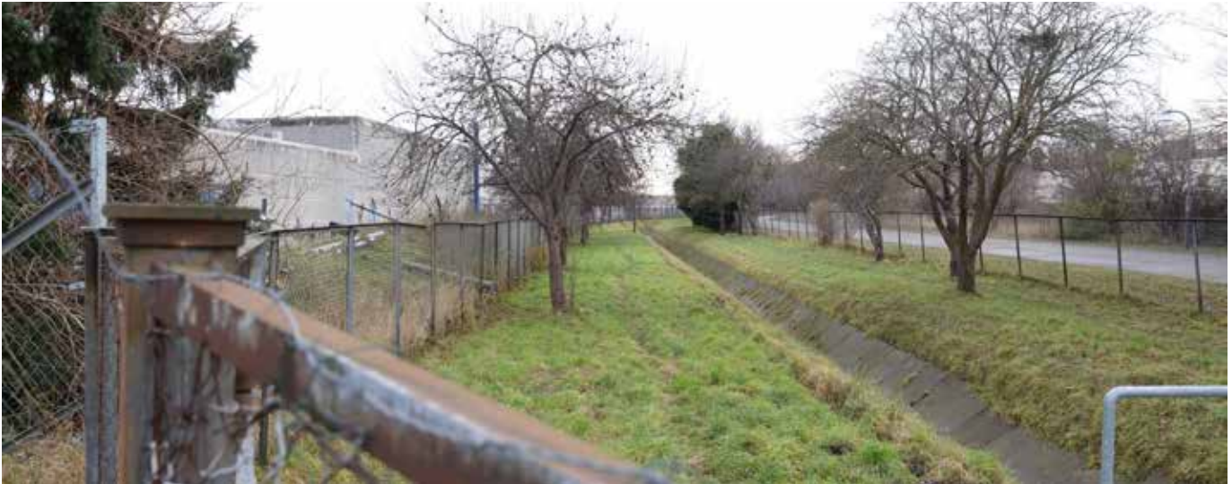
Hvissingegrøften er idag afskærmet og utilgængelig
