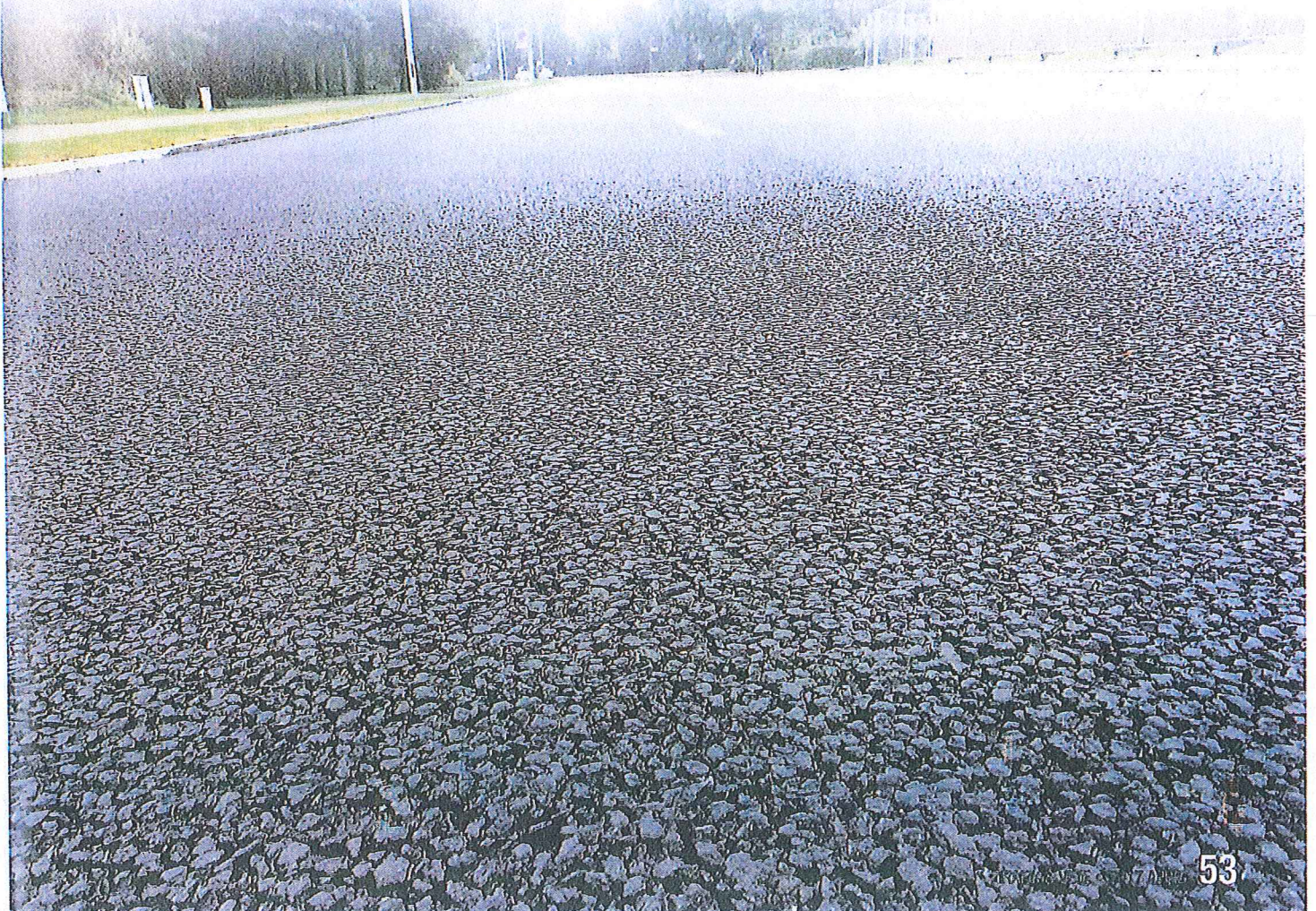
Figur 3. Multifunktionel drænasfalt: Nydelig, plan og ensartet belægning med tydelig hulrumsstruktur. Trods relativt tung trafik med hyppig busdrift kunne der efter et år ikke konstateres signifikant sporkøring på teststrækningen på Korsdalsvej i Rødovre.
