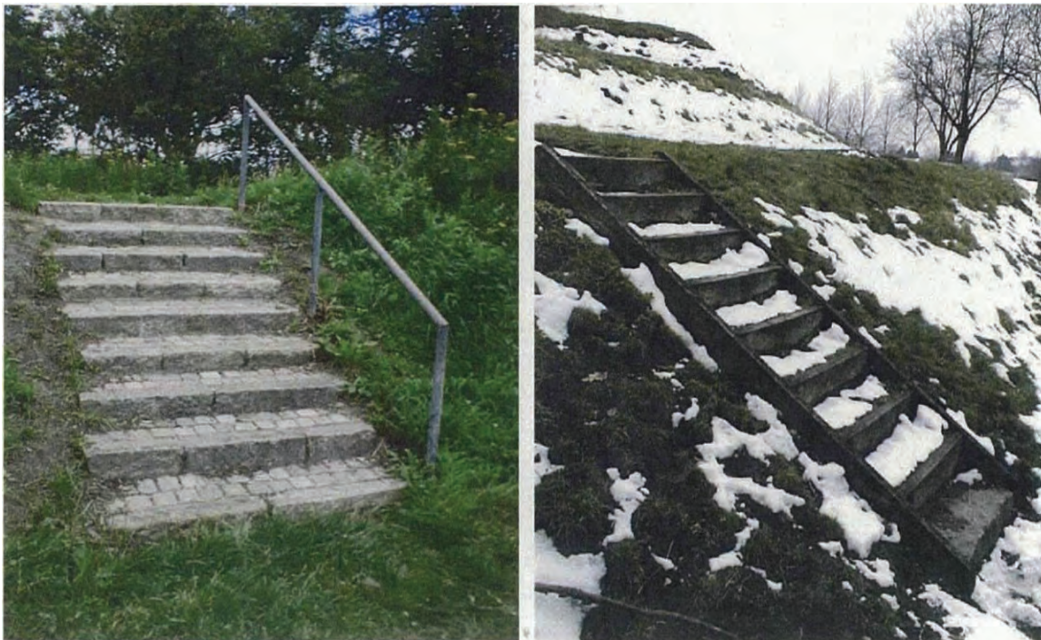
Figur 8: Trappe sat af kant- og chausseesten (t.v.) og vangetrappel af træ (t.h)
