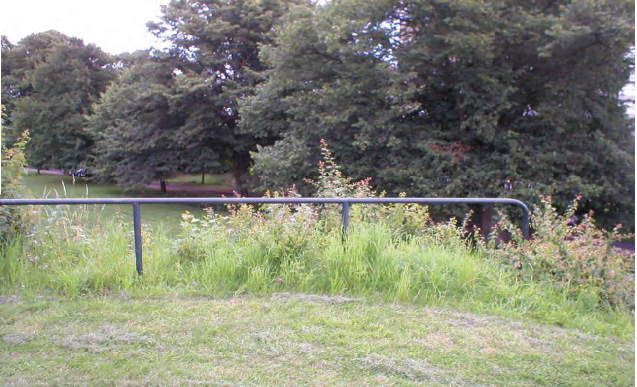
Figur 10: Afskærmende rækværk ved bygninger, hvor der er fare for styrt.
