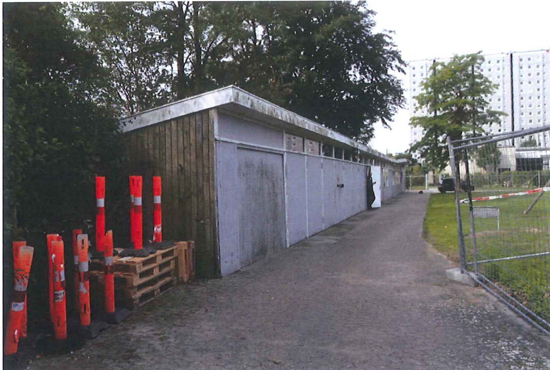
Den tidligere kioskbygning med en nyere tilføjelse.
