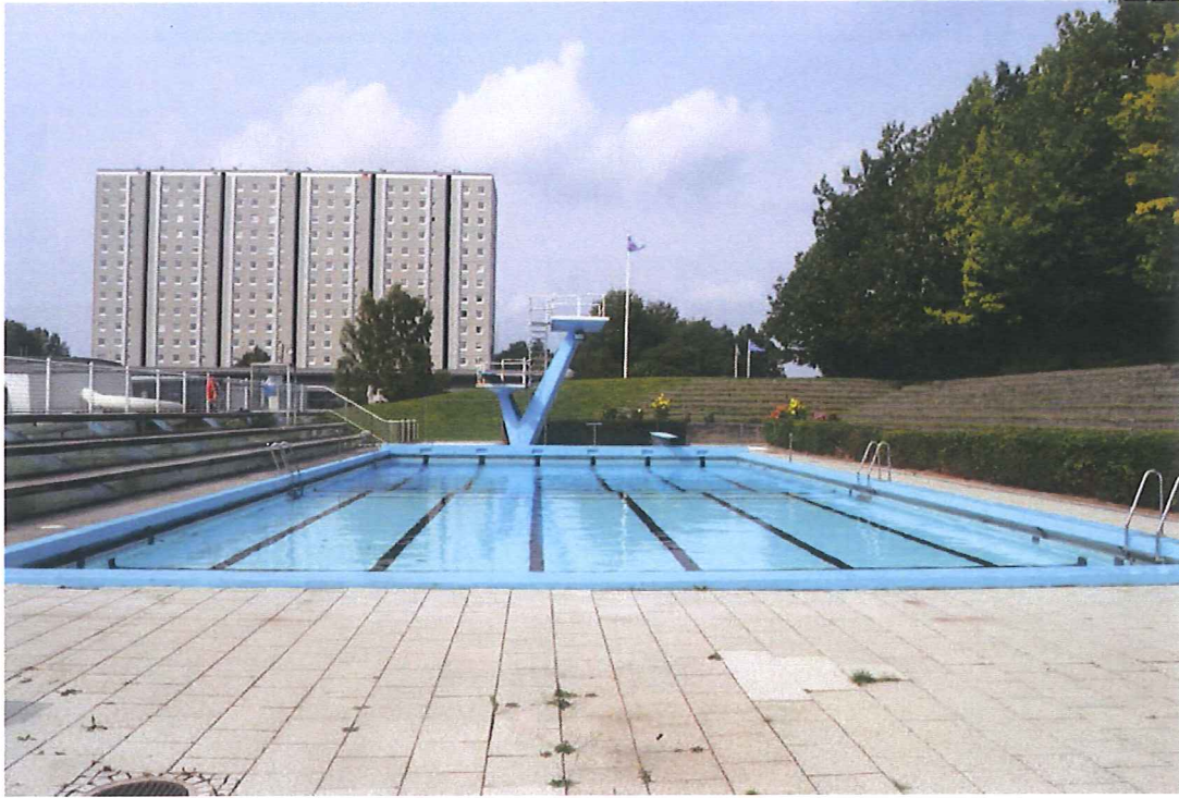
Det store svømmebassin med boligbebyggelse i baggrunden.
