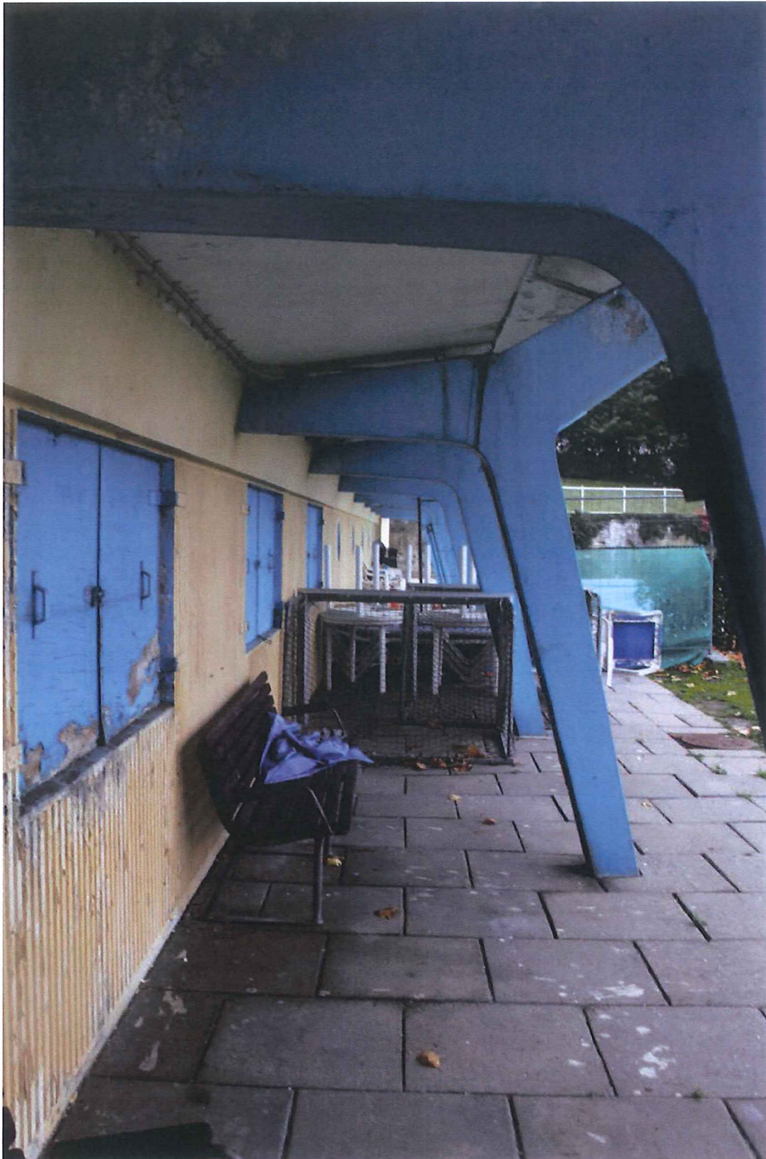
Konstruktionen under det store svømmebassin med vinduer, hvor man kan kigge ind i bassinet.
