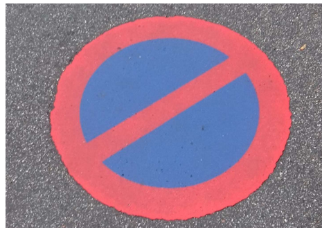
Eksempel på "Parkering forbudt" afmærket på asfalten. Det kan overvejes ved cykelsluser, hvor bilerne parkerer tæt på.
