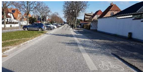
Damhus Boulevard ved Rødovre Station. For lidt manøvreareal giver risiko for, at bilerne kører ind over cykelbanen, når de parkerer.
