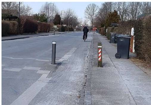
Brandholms Alle. Det er skønnet på stedet, at cykelsluserne er smallere end 1,25 m. Det betyder, at nogle cyklister vil benytte bilernes rute gennem vejindsnævringen.
