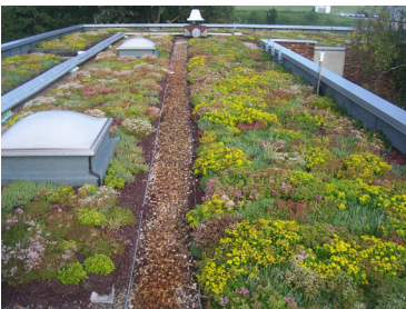
Referencefoto af et grønt tag. Med grønne tage menes der levende tage, som f.eks. kan være med græs, sedum, urter eller blomster med græs m.fl.
