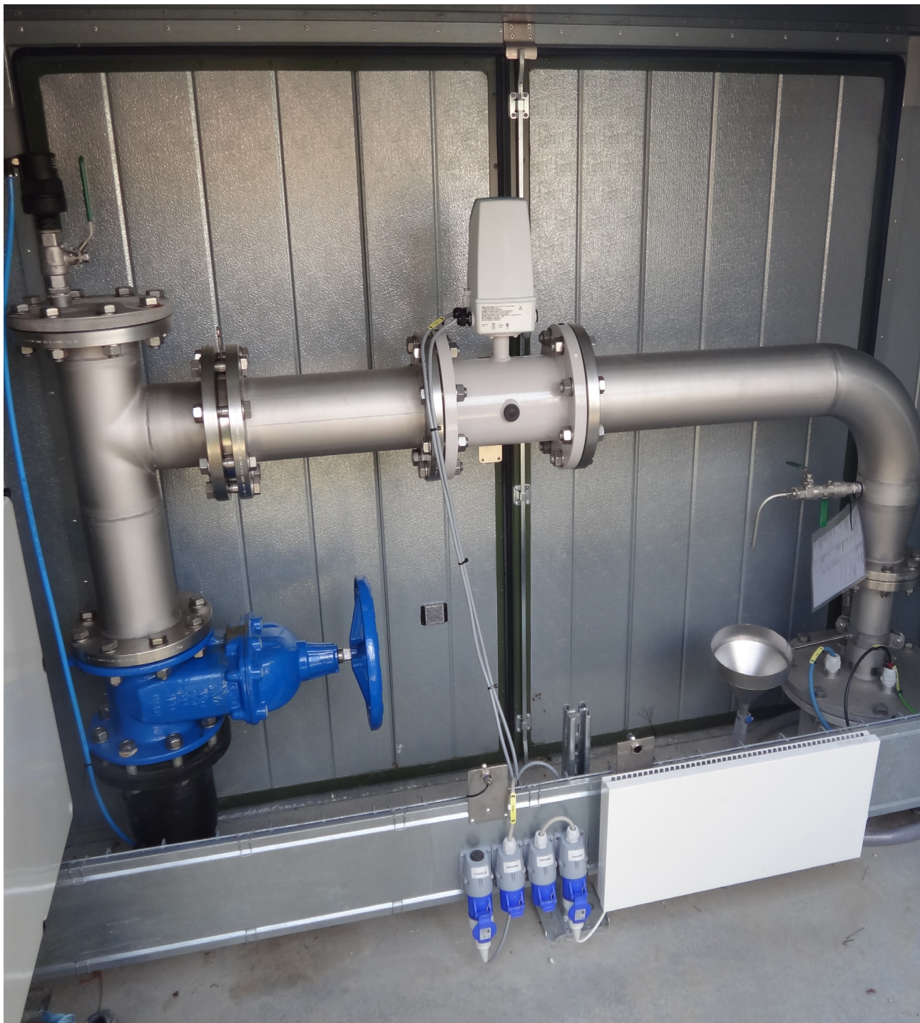
Ny boring til Espevang Vandværk i Rødovre.
