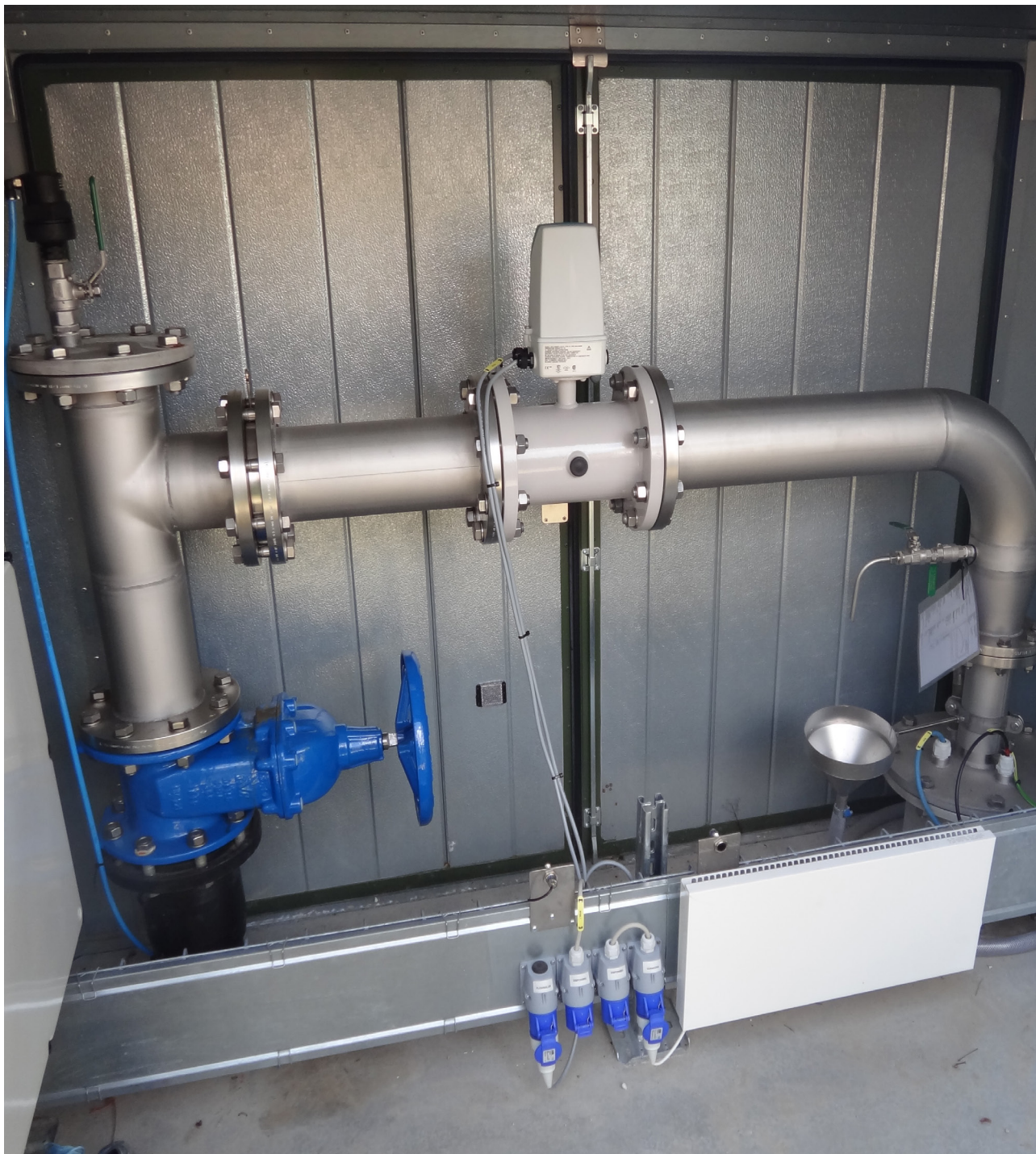
Ny boring til Espevang Vandværk i Rødovre.
