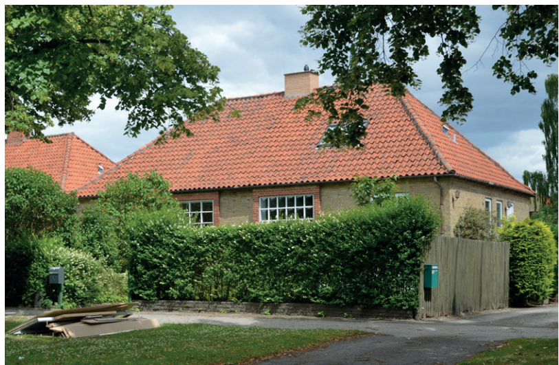
Doppelthusene på Hendriksholms Boulevard.
