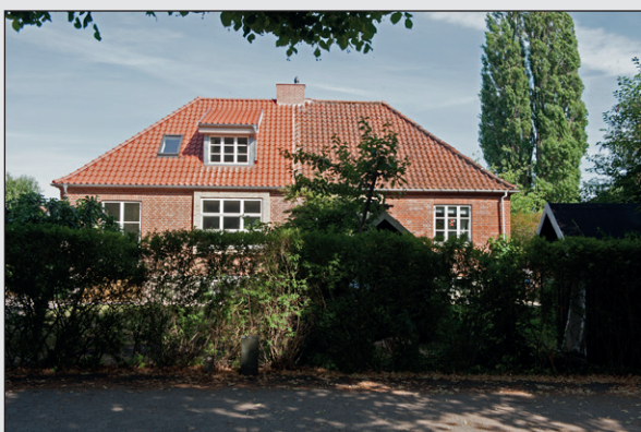
Hendriksholms Boulevard 47-49 Foto: 2013 Matr. 4si og 4sk af Rødovre By, Hendriksholm
