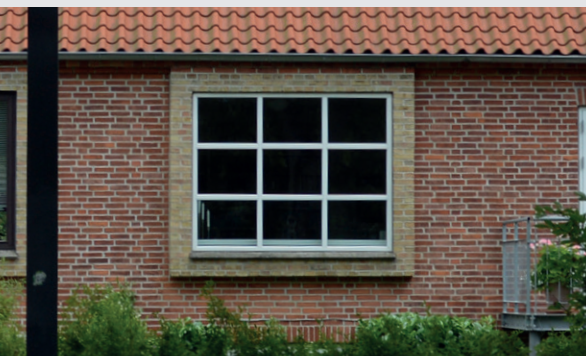
Lisene omkring de midterste vinduespartier ved husene, der ligger 15 m fra vejskel.
