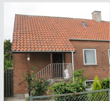
Øverst: malet havefacade, kælderetage i tegl, original vindues opdeling Nederst: Ingen tagudhæng og gelænder i hvidmalede jernprofiler
