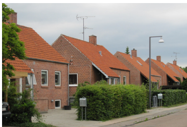
Husfacader mod villavej
