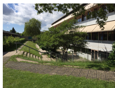
Hovedbygningen set fra østsiden.
