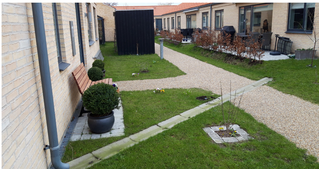
I Rødovre indtænkes klimatilpasning i byudviklingen. Her ses et eksempel på lokal håndtering af regnvand i Irmabyen.
