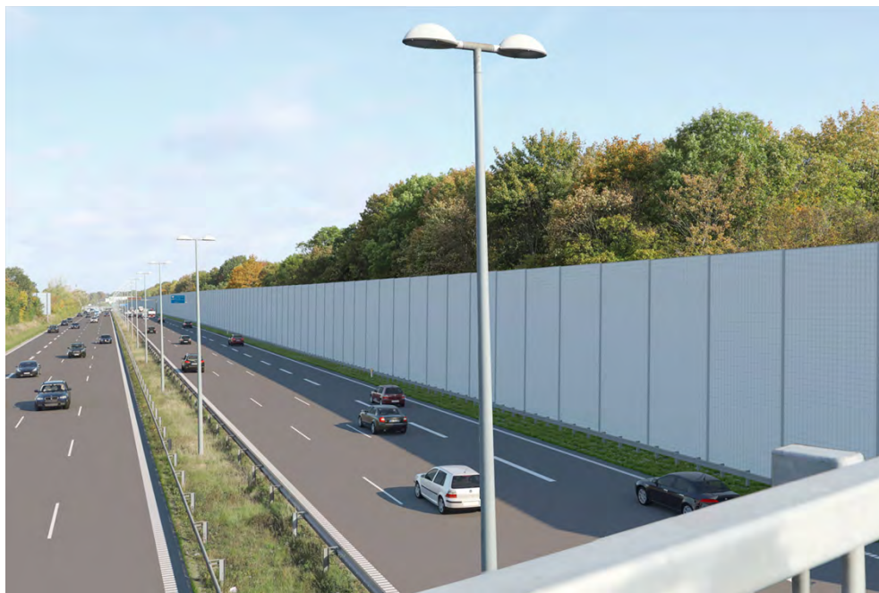
Figur 3-16 Eksempel på almindelig 9 meter høj støjskærm.
