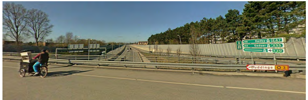
Figur 10-4 3 - De visuelle forhold mellem Nybrovej og Jyllingevej. Her fra overføringen af Buddingevej. Kørebane, støjskærme og vejdstyret er synlig fra overførte veje og stier. Set fra nord mod syd. Foto, COWI.
