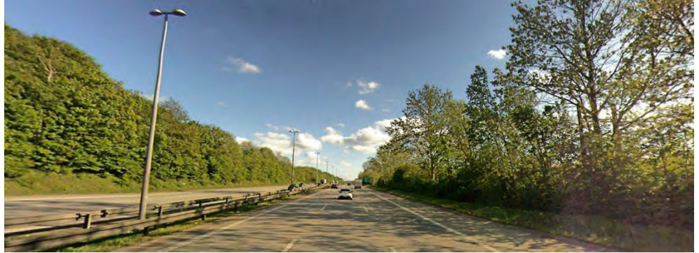
Figur 10-7 6 - De visuelle forhold mellem Jyllingevej og Amagermotorvejen. Motorvejen er på det meste af denne strækning omgivet af tæt beplantning, blandt andet langs Vestvolden som ses vil venstre i billedet. Set fra nord mod syd. Foto, COWI.
