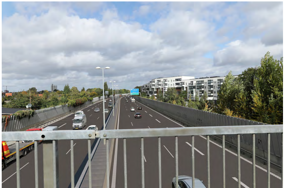
Figur 3-3 Visualisering af Motorring 3 efter udvidelsen, hvor det eksisterende nødspor er omdannet til kørespor.
