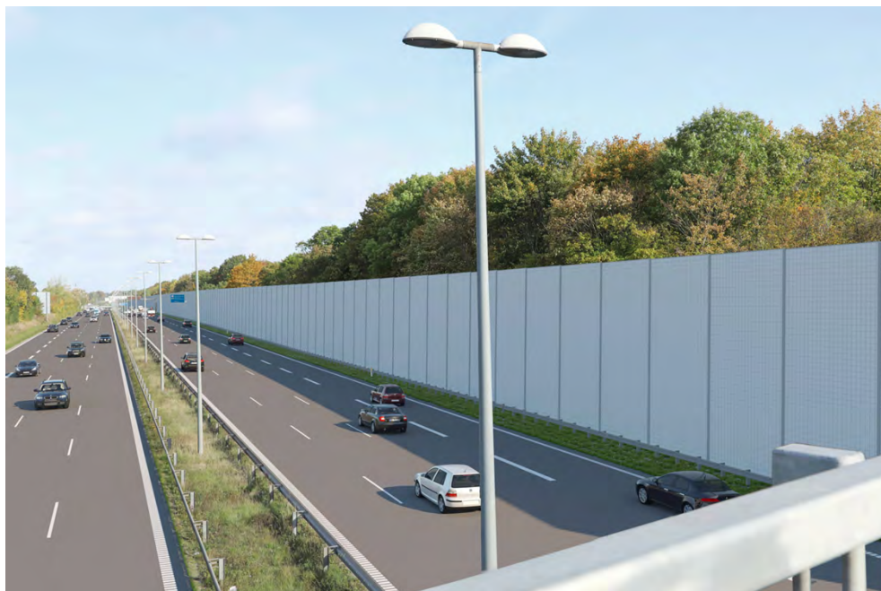
Figur 10-15 Udsigt fra Park Alle mod nord med støjskærm på 9 meter langs Vestvolden. Foto og visualisering: COWI.
