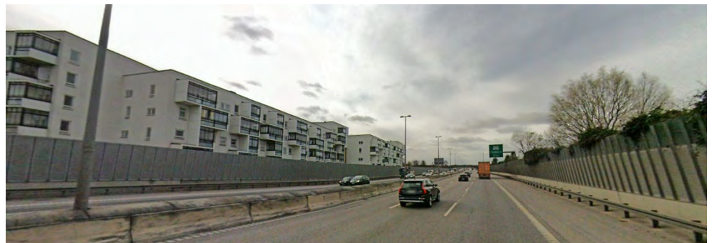
Figur 10-5 4 - De visuelle forhold mellem Nybrovej og Jyllingevej, enkelte steder har ejendomme indblik til selve kørebanen, her ved Brunevang i Rødovre. Set fra nord mod syd. Foto, COWI.
