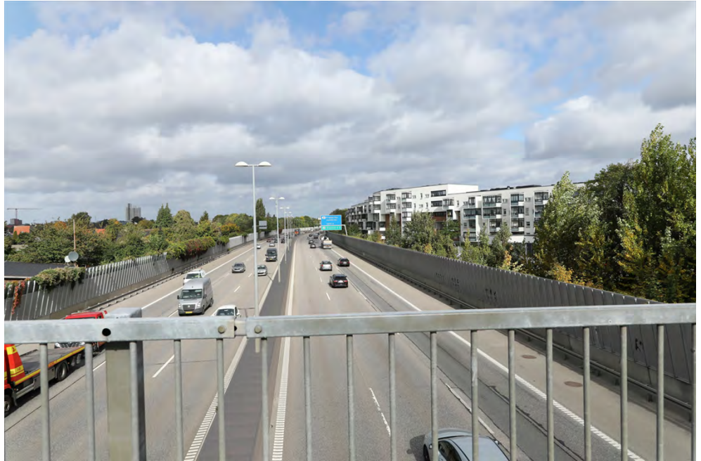
Figur 3-2 Motorring 3 som den ser ud i dag med tre kørespor og et nødspor.
