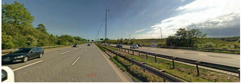
Figur 10-9 8 - De visuelle forhold umiddelbart syd for Holbækmotorvejen. På den sydligste del langs boldbanerne vest for vejen forløber en støjvold, hvorfra motorvejen er synlig. Set fra nord mod syd. Foto COWI.
