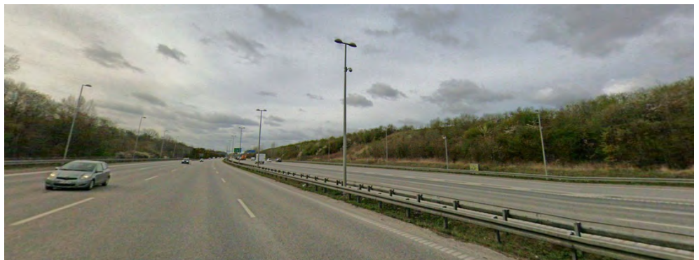
Figur 10-8 7 - De visuelle forhold mellem Jyllingevej og Roskildevej. Langs motorvejens vestside forløber en støjvold, hvorfra motorvejen er synlig. Set fra nord mod syd. Foto COWI.
