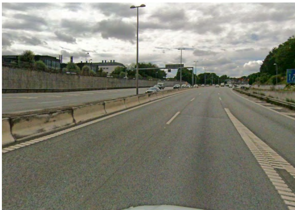
Figur 10-3 2 - De visuelle forhold mellem Lyngby omfartsvej og Nybrovej. Støttevægge og bagvedliggende erhverv ses til venstre i billedet. Set fra nord mod syd. Foto, COWI.
