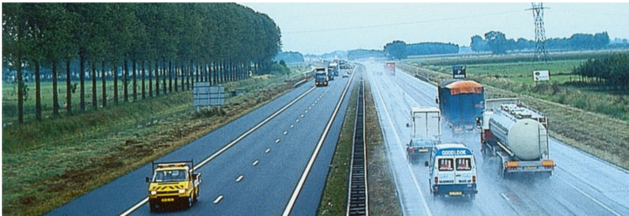
Figur 25 Drænasfalt (venstre side) på hollandsk motorvej en regnvejrsdag, kilde: VBW-Asfalt - Creative Commons Attribution-Share Alike 3.0 Unported license
