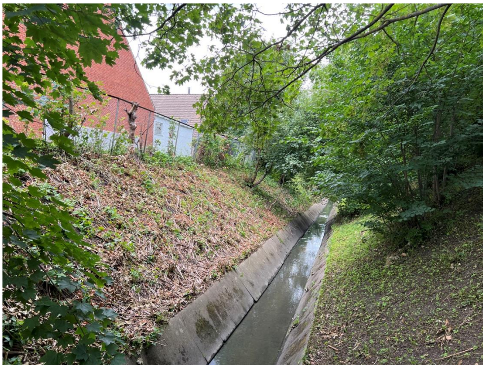
Figur 4-60 Grøft med stejle skrånninger ved Jyllingevej
