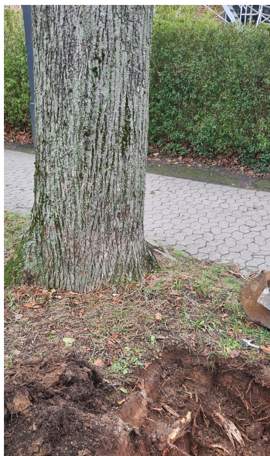
Graveskader på træers rødder, har alvorlige konsekvenser for træers sundhed og forkorter deres levetid betragteligt. I værste tilfælde dør træerne inden for 5 år.
