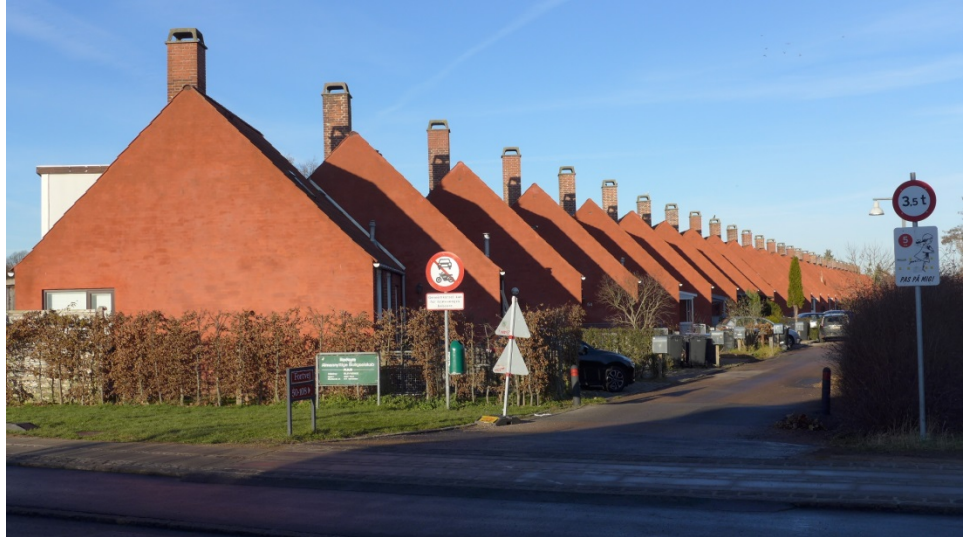
Rækkehusbebyggelsen Islev Vænge er bevaringsværdig.
