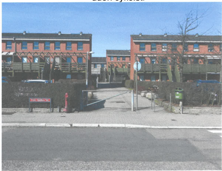
Indkørsel til tunnelen under Roskildevej effektivt spærret
