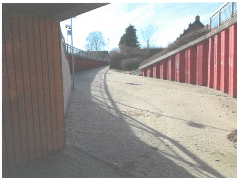
Gennem tunnelen under Tårnvej
