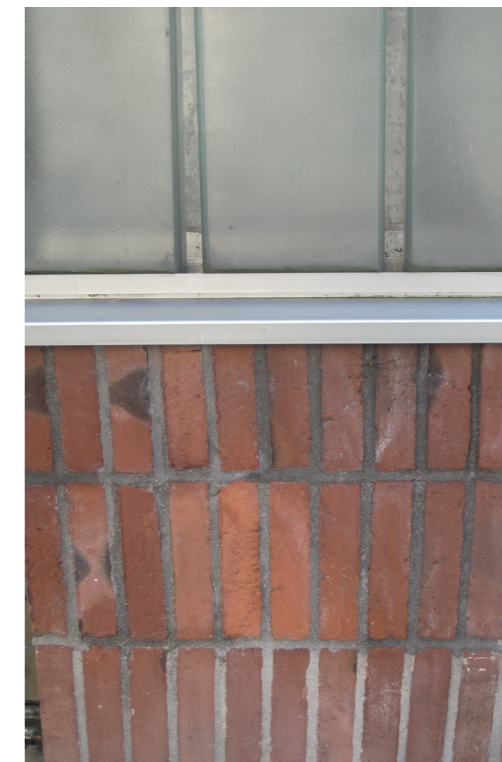
Referencefoto: Murværk, stål og glas
