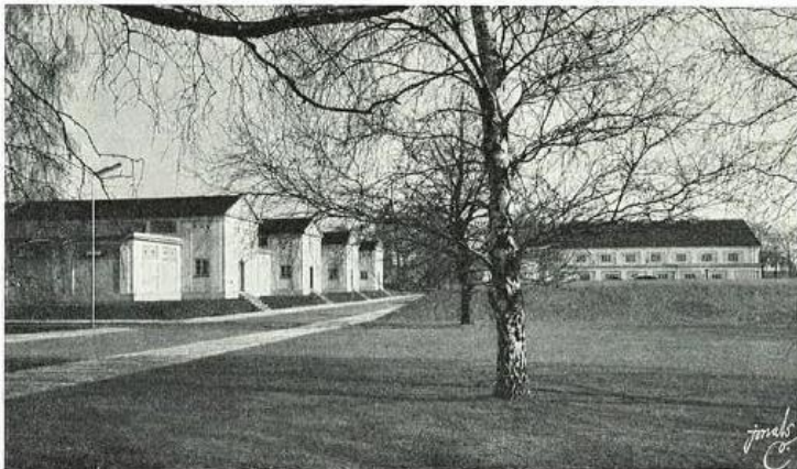
Fig. 13. Vandværket ved Islevbro.
