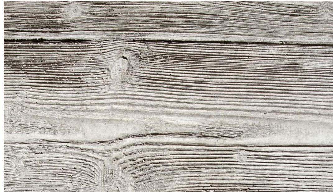
In situ støbt beton. Aftrykket fra forskallingsbrædderne bevarer et slægtskab til den eksisterende træbeklædning
